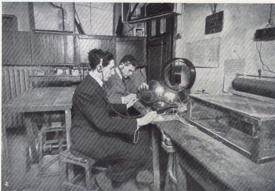
FIG. 7 - Stazione radioricevente del Laboratorio-Scuola di Radiotrasmissioni (R. Istituto Tecnico C. Cattaneo di Milano). Due allievi stanno registrando segnali provenienti dalla stazione Nordamericana di Annapolis. Le lampadine che si vedono accese sono i triodi o valvole termoioniche.
