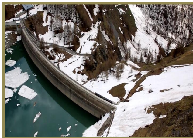
La diga di Bardonecchia
